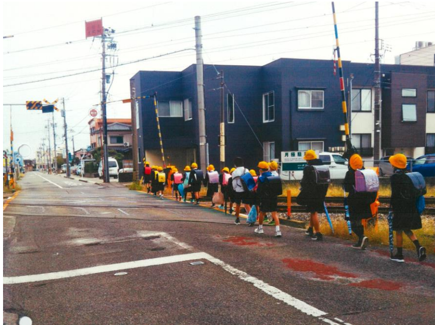
整備前（糸田道踏切道）
