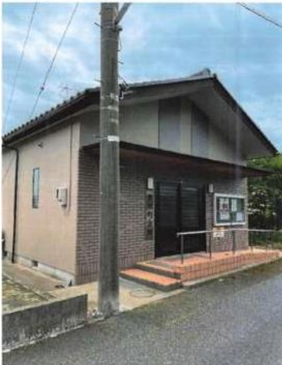
黒田町会館（修繕）
