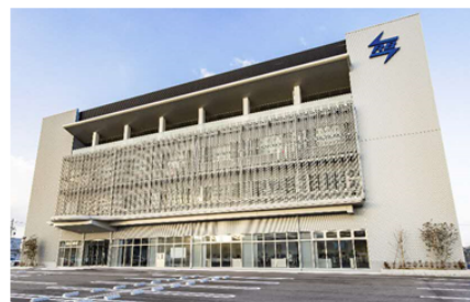
2021年4月に竣工した本社増築棟
