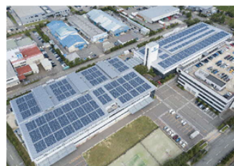
白山工場屋上太陽光パネル
