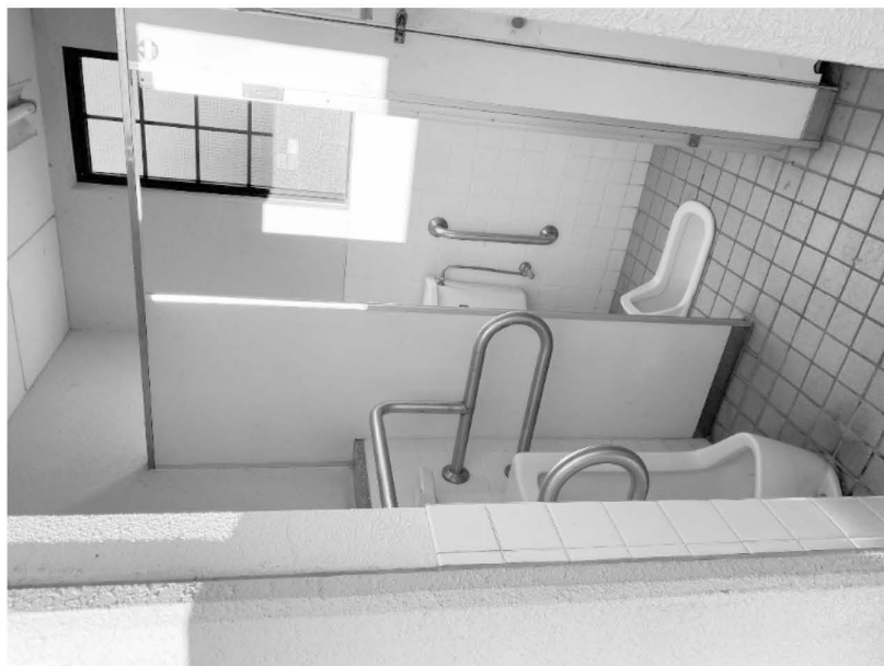
【上荒屋にれのき公園トイレ内観（令和2年10月15日撮影）】
