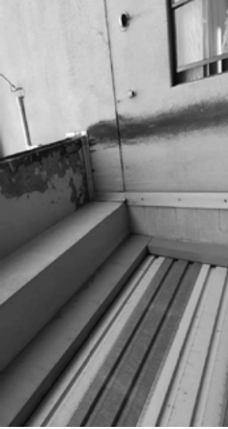
ガレージ入口の天井塗装の状況
