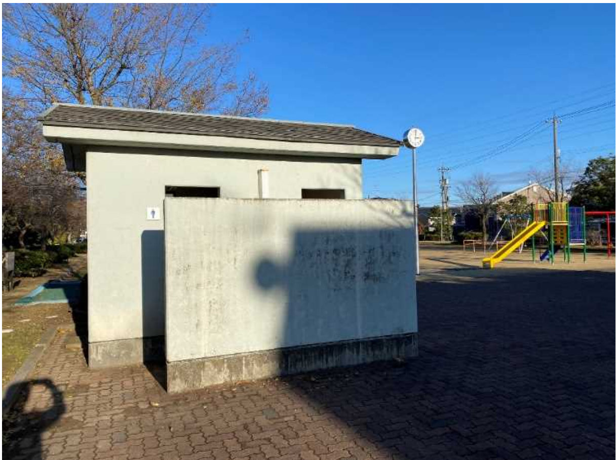
【上荒屋にれのき公園トイレ外観（令和2年10月15日撮影）】
