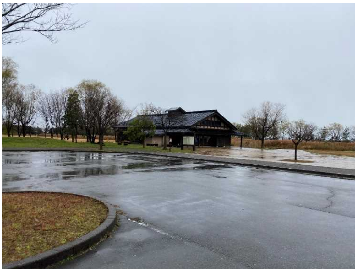
【こなん水辺公園事務所外観（令和2年12月14日撮影）】
