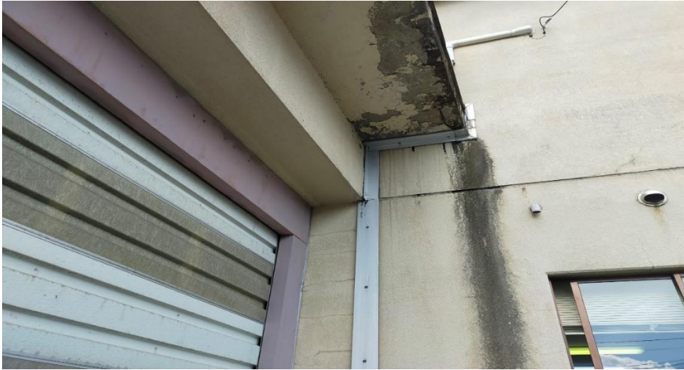
ガレージ入口の天井塗装の状況
