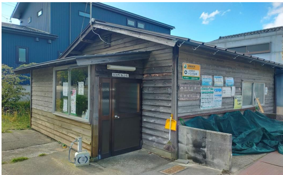
道路から見た建屋
