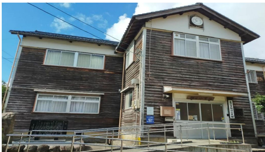
スロープのある正面入口
