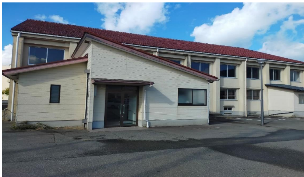
正面から見た施設
