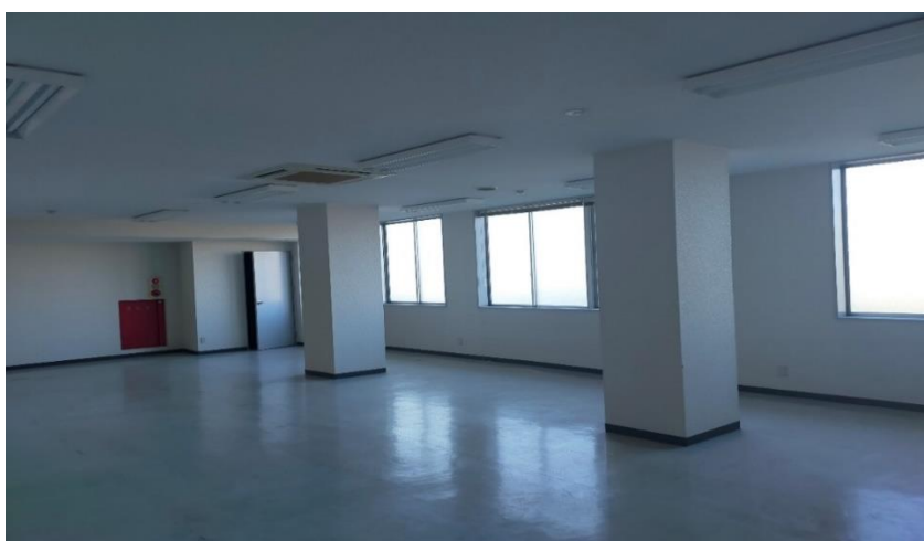
利用されていない施設内部
