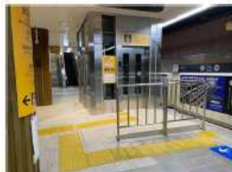
天神駅東口エレベーター (令和3年10月供用開始)
