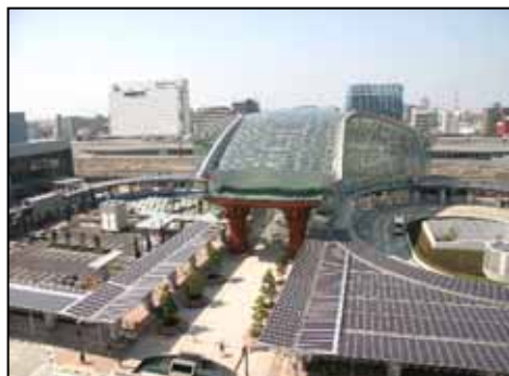
金沢駅東広場 (もてなしドーム)
