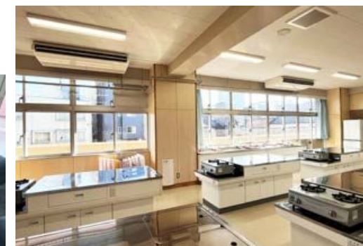
特別教室及び体育館の空調設備の整備
