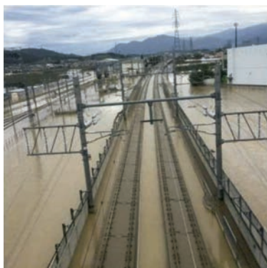
北陸新幹線の被害状況(左:本線の浸水、右:浸水した車両)
