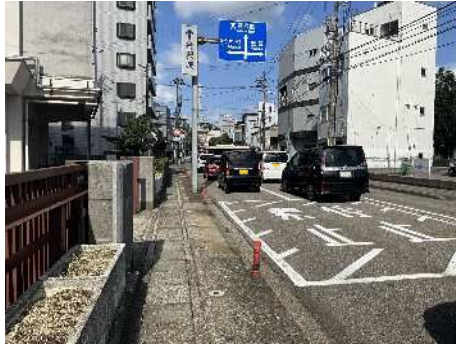
本多通り（広坂・新桜坂線）歩道
