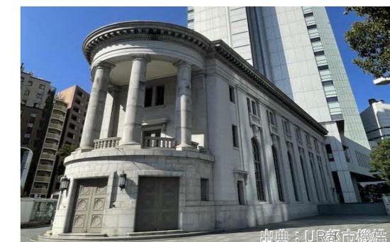
横浜アイランドタワー(横浜市)
