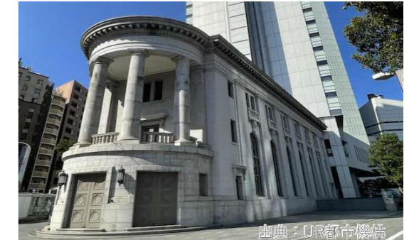
横浜アイランドタワー(横浜市)
