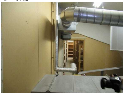
物置・排煙機械室
