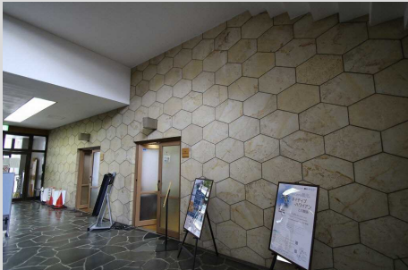
1階ホール壁面に亀甲紋を意識した 六角形の石、床は鉄平石の乱貼り
