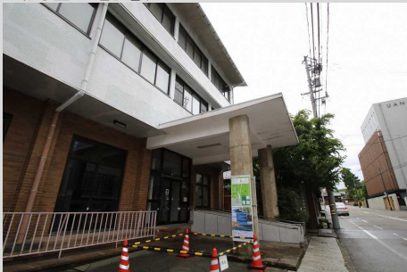
入口の庇を支える多角形の柱 (縦線を増やし、ほっそり見せている)
