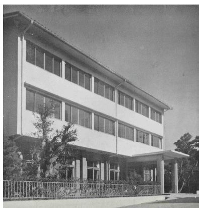
建築当初の外観正面（南）
