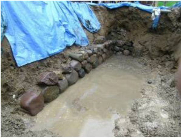
下段石積(石積①②)
