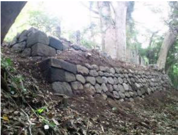
塀跡の石積み(上)と基壇石垣(下)
