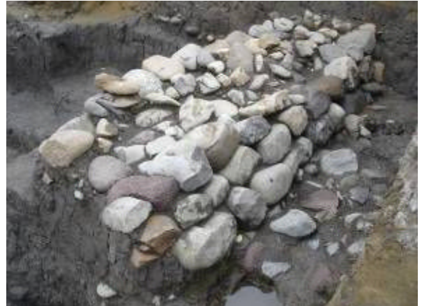
塀基礎の石積み
