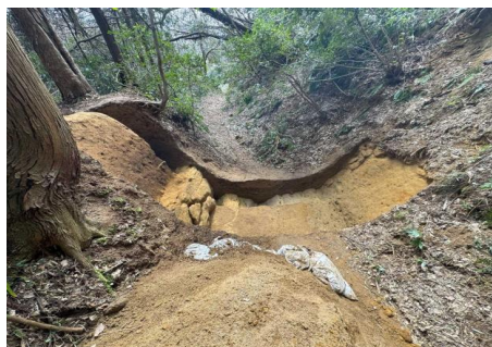
①東長江町地区 サブトレンチ掘削状況
