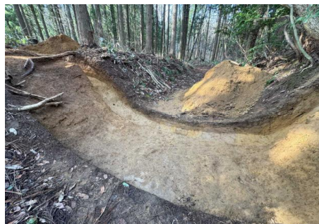
②不室町地区 サブトレンチ掘削状況
