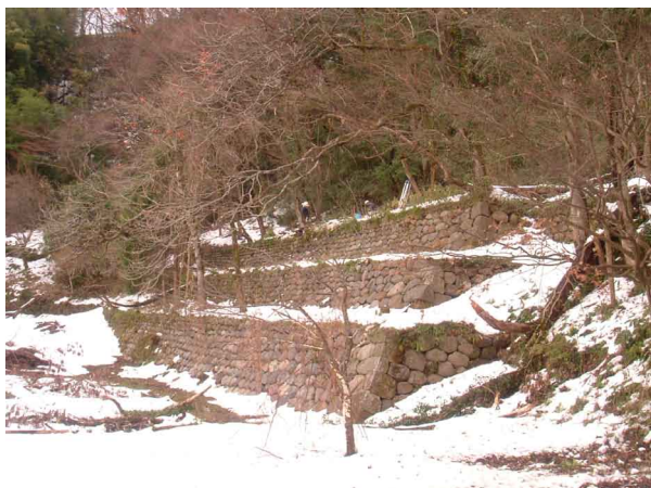
「三段石垣」全景
