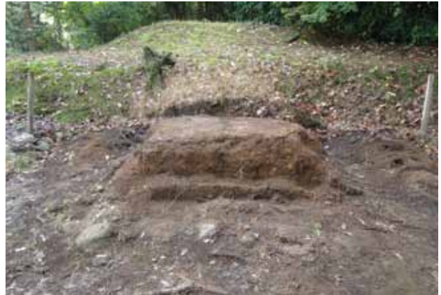
石廟解体後状況
