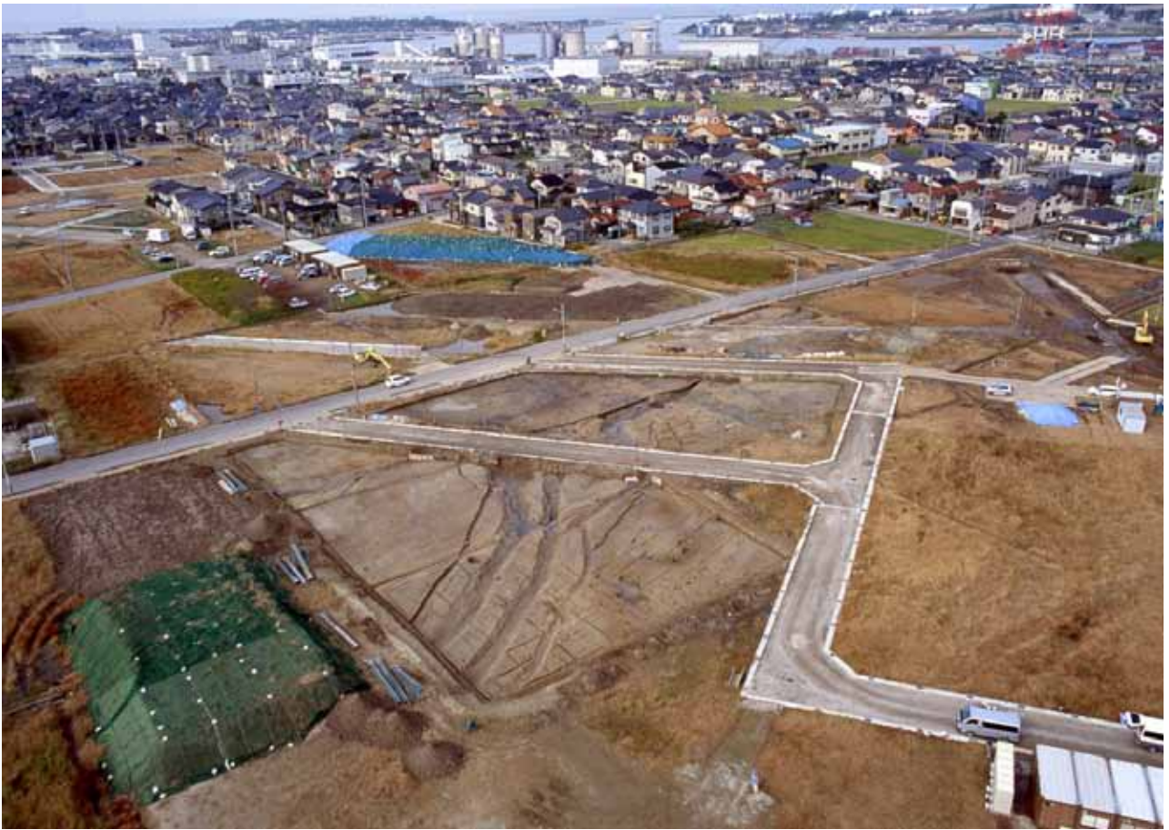
A5区・A6区全景（南東から）
