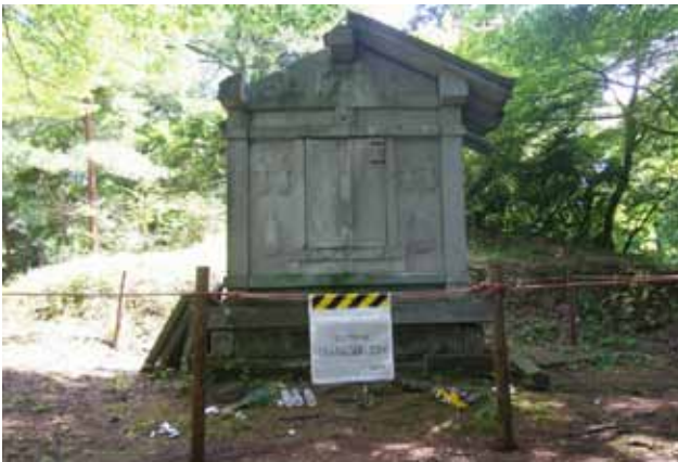
村井千世墓石廟(解体前)
