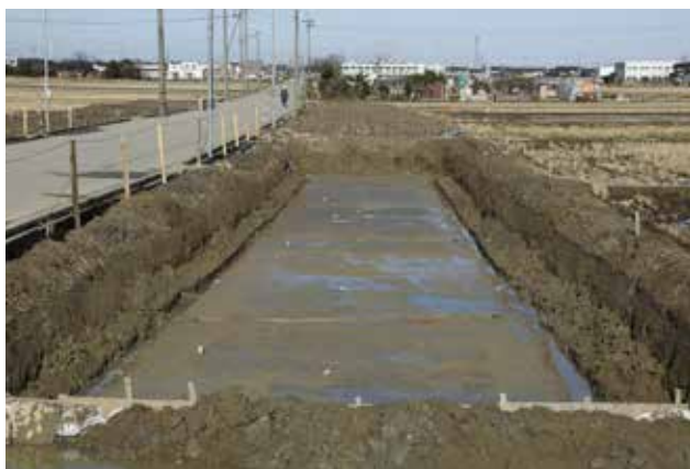
完掘状況（3区 南から）
