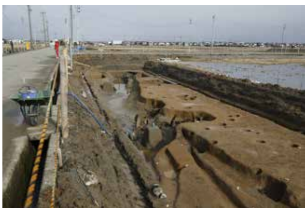
完掘状況（5区 南から）
