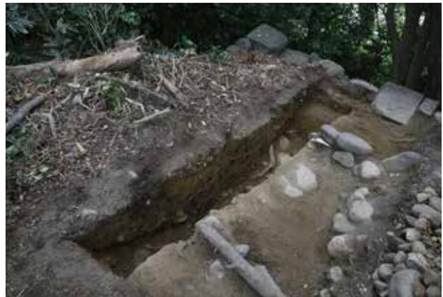
石垣1の裏込め部（北から）
