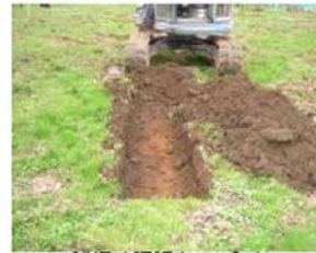
試掘確認調査の様子
