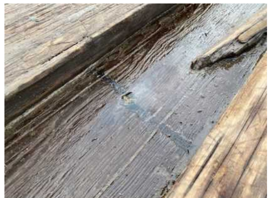
板材鋸状況（近景）
