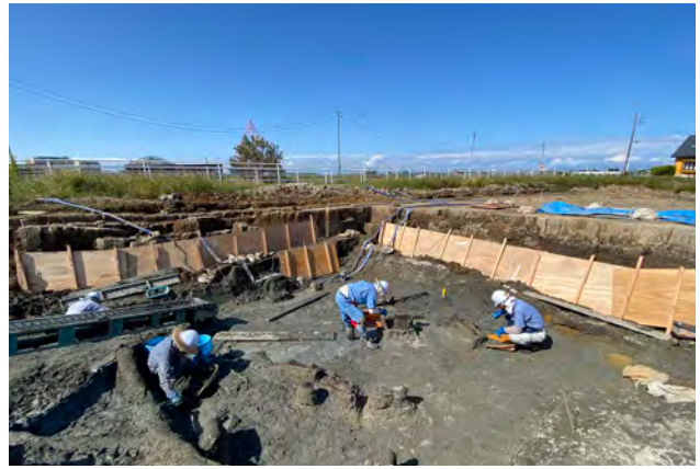
1区 弥生～古墳の川 作業風景
