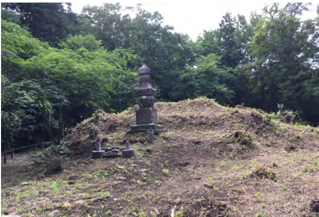
豪墓 五輪塔解体前状況
