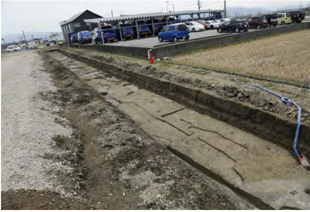
A 区全景（西から）
