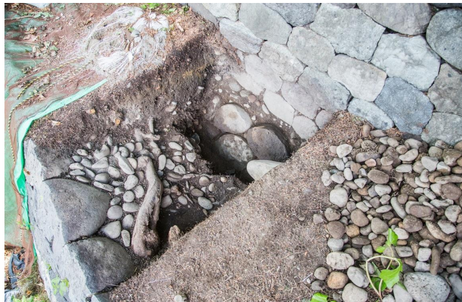
A区(下段石積裏込と背後の埋没石積)
