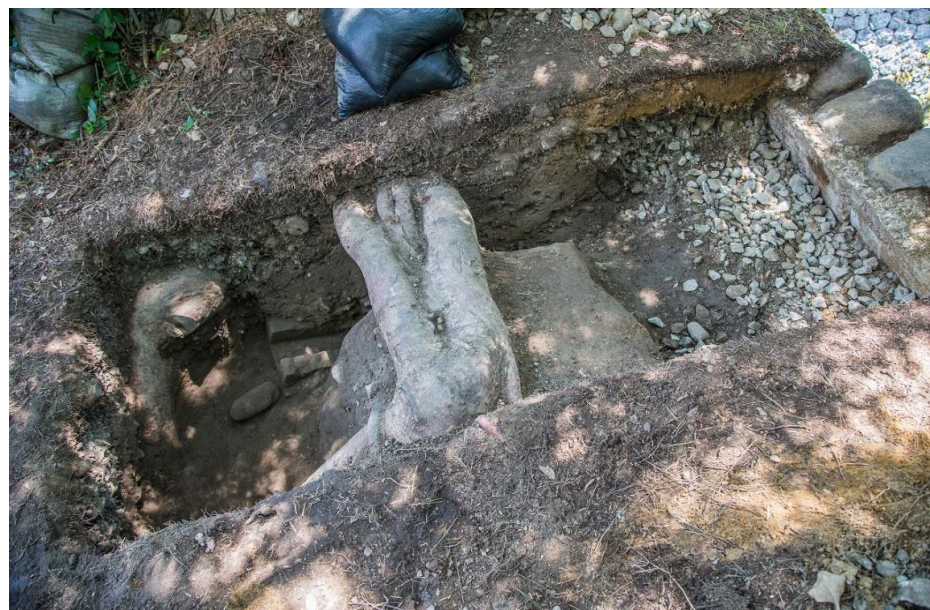
C区(上段石積改修部裏込と近代盛土)
