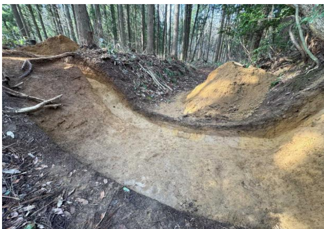
②不室町地区 サブトレレンチ掘削状況
