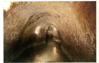
長坂用水法師の隧道 (金沢市指定史跡)
