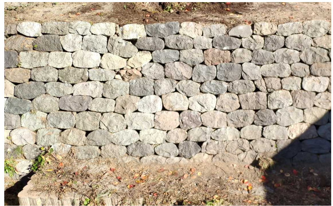
下段石積 復旧完了
