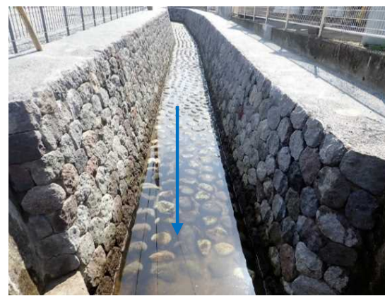
整備後（令和3年度）
