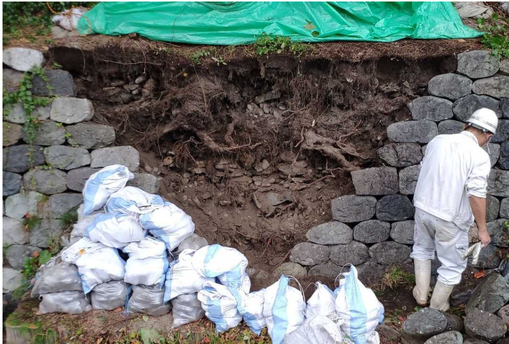
下段石積 根の状況
