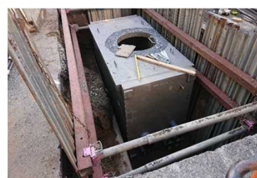
旧鶴来街道(県道～六斗の広見、蛤坂)修景整備事業 ハンドホール設置状況 R3
