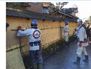
土塀の薦掛け作業
