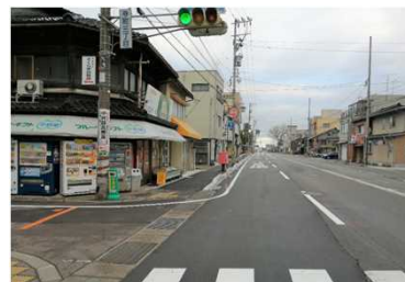
(都)専光寺野田線寺町3丁目～5丁目無電柱化事業 管路及びハンドホール設置 R 3
