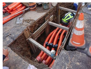
観音町通り無電柱化事業 管路設置状況 R3
