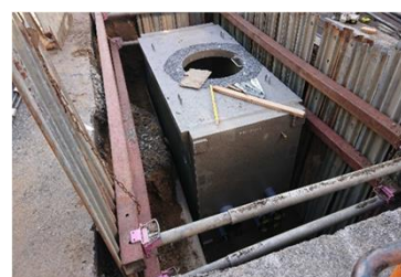
旧鶴来街道(県道～六斗の広見、蛤坂)修景整備事業 ハンドホール設置状況 R3
