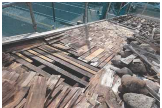
修繕工事中の板葺き屋根
