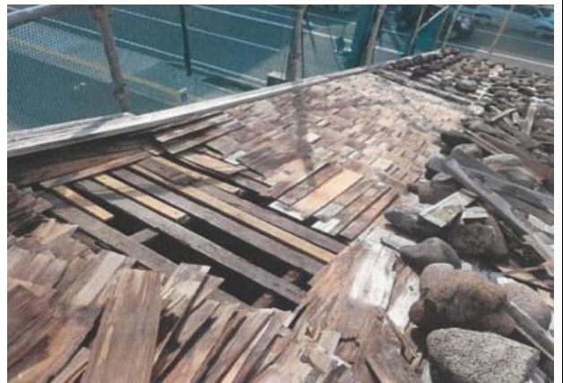
修繕工事中の板葺き屋根
