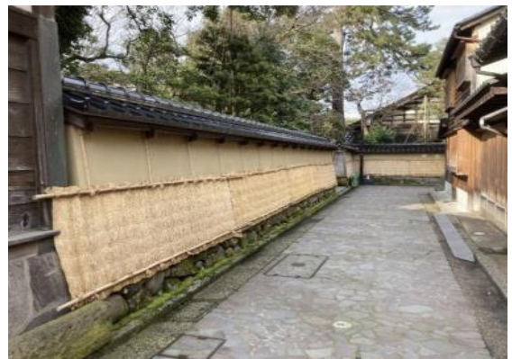
雪吊りの様子
