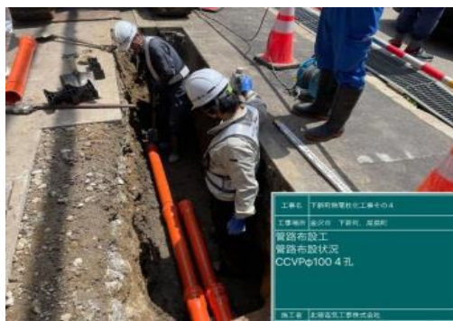
電線管路設置
