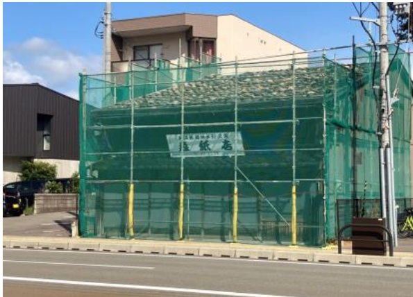
外部足場設置
