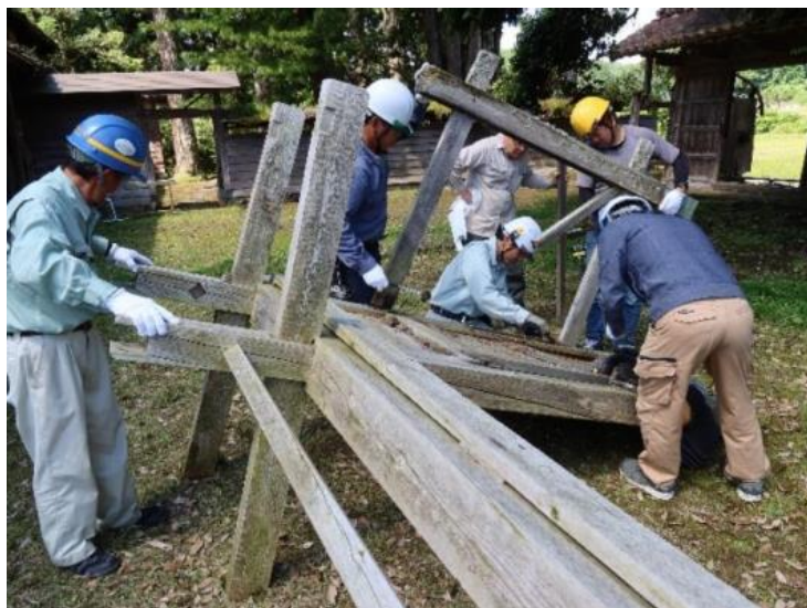
【応急復旧作業】
