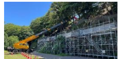
石垣解体修理工事の状況
