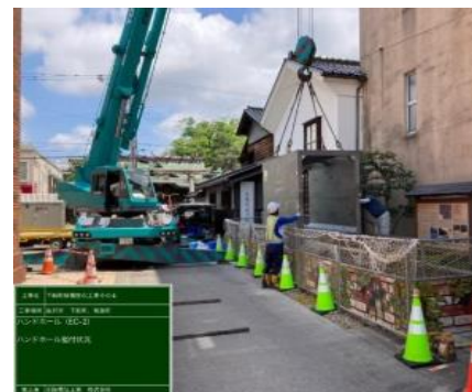
ハンドホール設置(既整備箇所)
