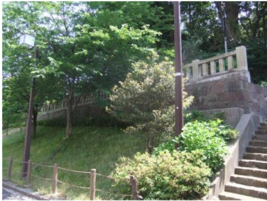
金沢城・兼六園周辺に見る石垣（尾山神社）
