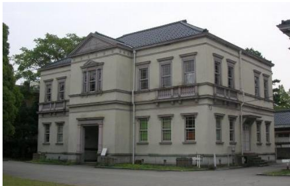
旧第九師団司令部庁舎（現石川県庁舎石引分室）
