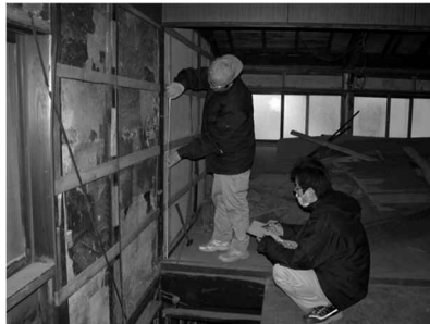
主要軸組架構の実測・野帳記録
