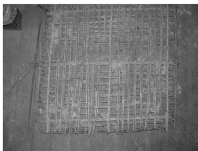
土壁下地（小舞）の仕様調査
