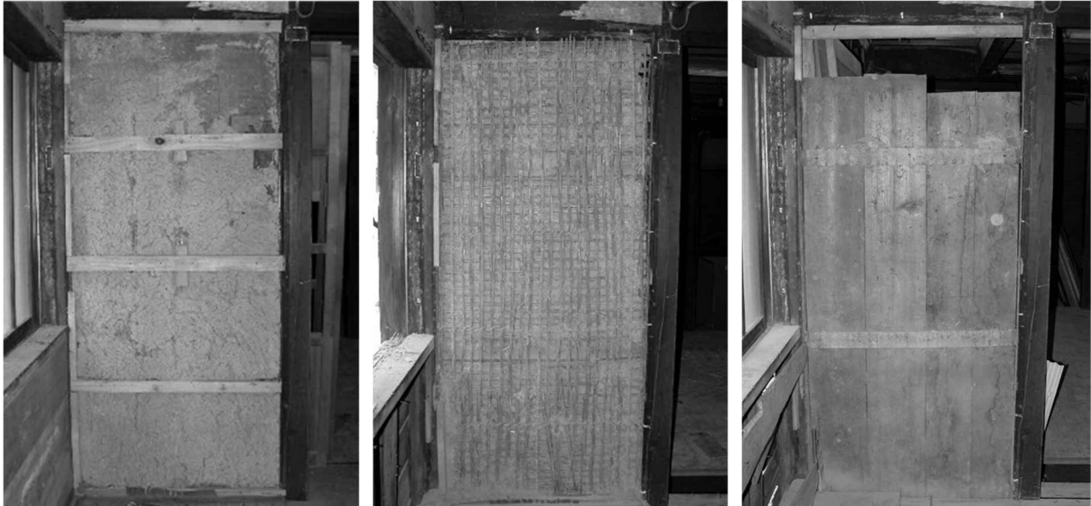
壁の仕様調査・土壁塗層
