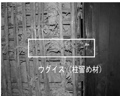
土壁下地（小舞）の仕様調査
