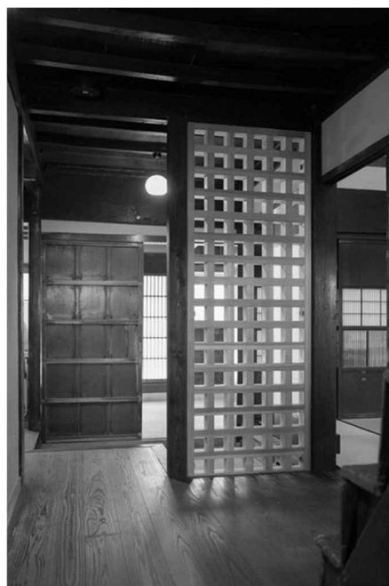
写真7.4 格子壁による補強例 (金澤町家情報館)
