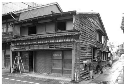
部分解体調査（柱の足元を確認）
