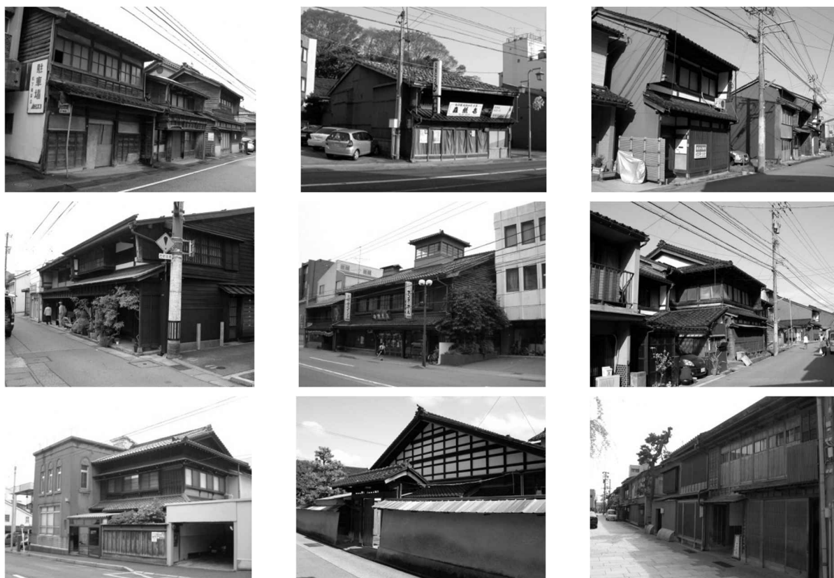
写真2.1 金沢の伝統構法木造建築物・町家の例
