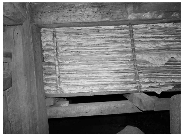
写真5.4 足固め材なしの例
