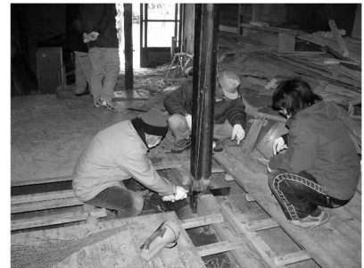
部分解体調査（柱の足元を確認）
