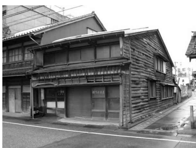
外観 正面・側面
