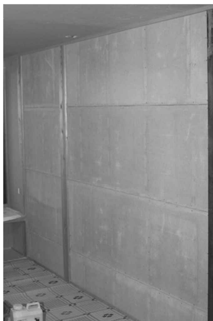
写真7.3 荒壁パネルによる補強例
