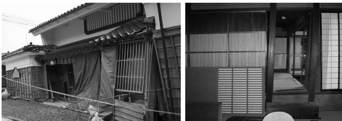
写真3.1 能登半島地震による被害例(左:角海家外観、右:旧酒井家内部)
