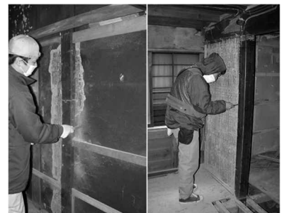
土壁の仕様調査
