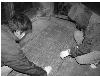
土壁下地（小舞）の仕様調査
