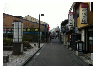
木倉町無電柱化事業 H24.3
