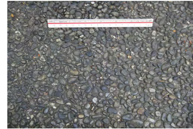
▲現況の洗出し舗装
