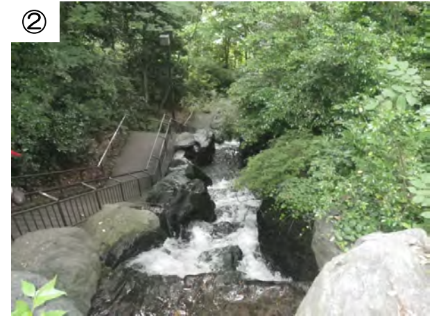
② ▲美術の小径・滝上流側より
