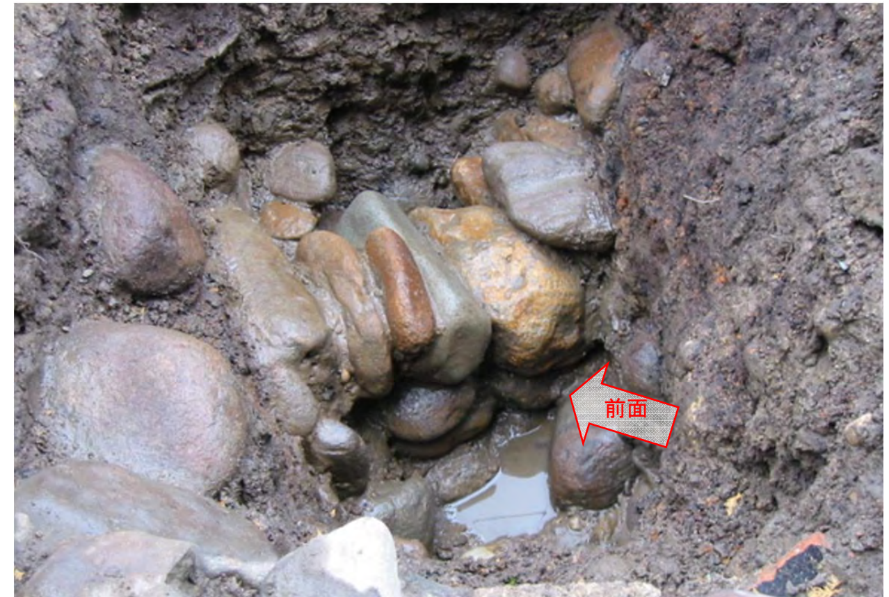
写真3 ②段階 2区 石垣5 石の狭い面を上下に配置
