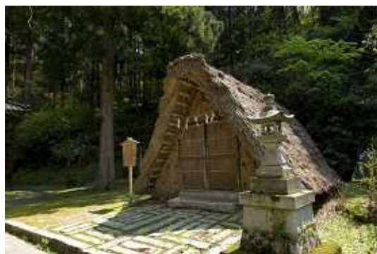
湯涌温泉にある氷室小屋
