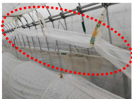
ハウス内が均一に暖まるよう、エアダクトを設置する
