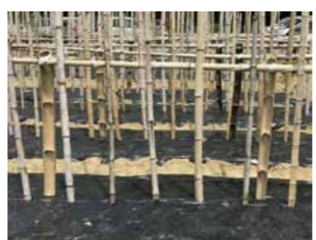
定植前に支柱を設置
