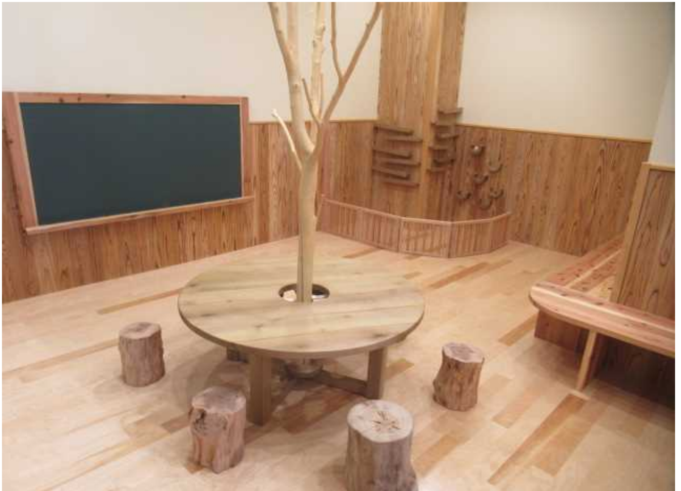
丸テーブル(ホオノキ)、フローリング・こし壁(スギ)
