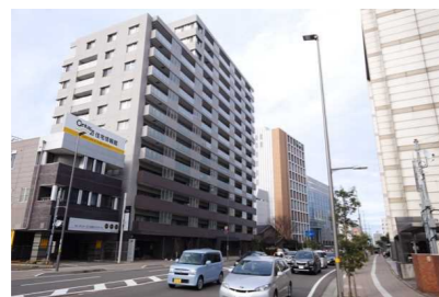
金沢駅周辺に建ち並ぶ高層建築物
