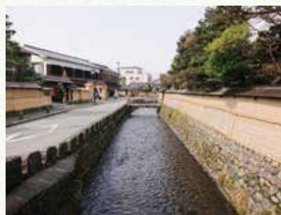
往時の土堀・石積護岸に改修した大野庄用水
