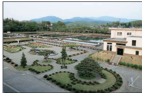
写真 末浄水場園地
