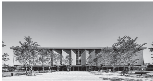
石川県立図書館 撮影:田中俊史(エスエス北陸支店)
