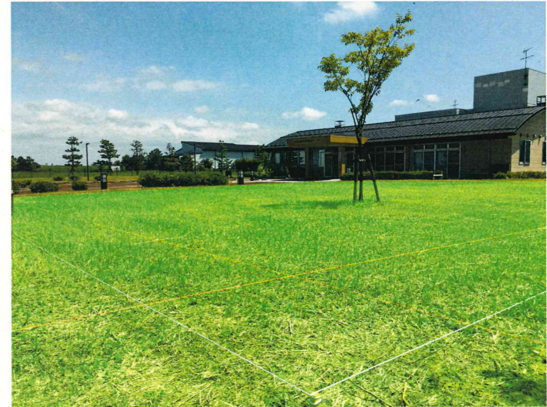
※今後、フェンス敷設及び給水設備等の工事を行います。（写真データ提供可）
