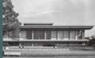
〔東京国立博物館東洋館〕(1969年) 撮影:新建築社写真部
