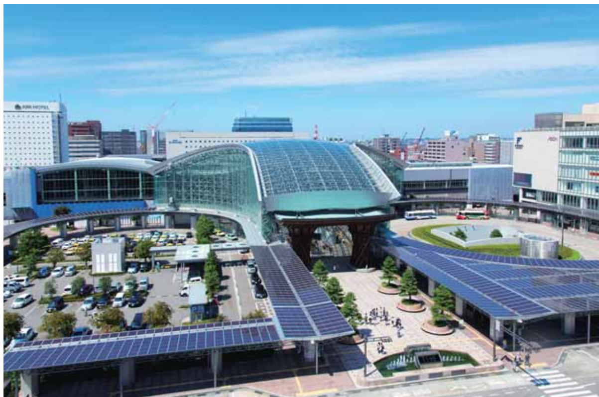
金沢駅 Kanazawa Station
