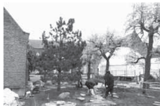
設置作業中の「濫觴の庭」
