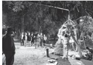
設置作業の様子
